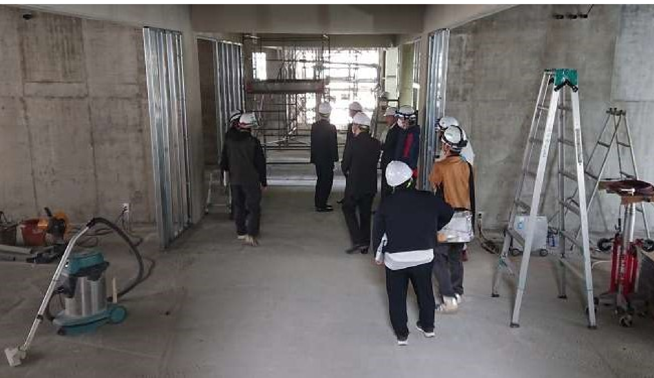
2階北側階段より南側を望む
