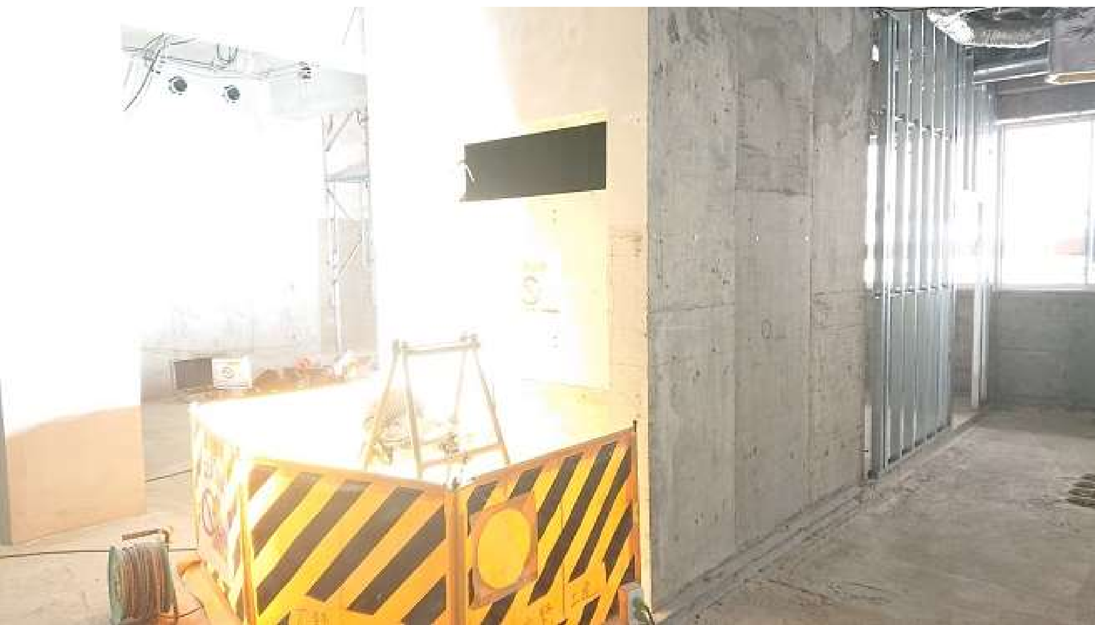
1 階ホール（エレベーター設置予定）
