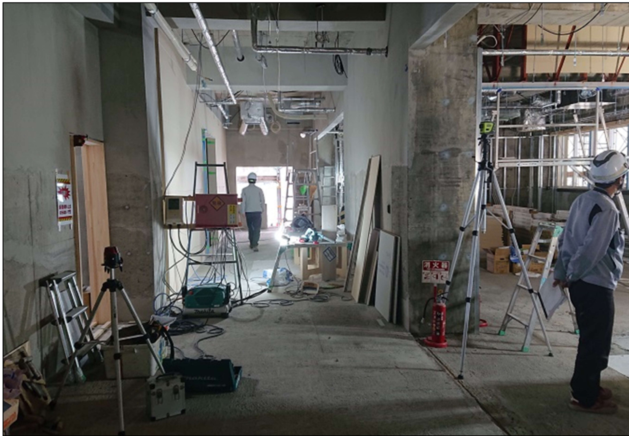
1階ラーニング・commonsより南側を望む
