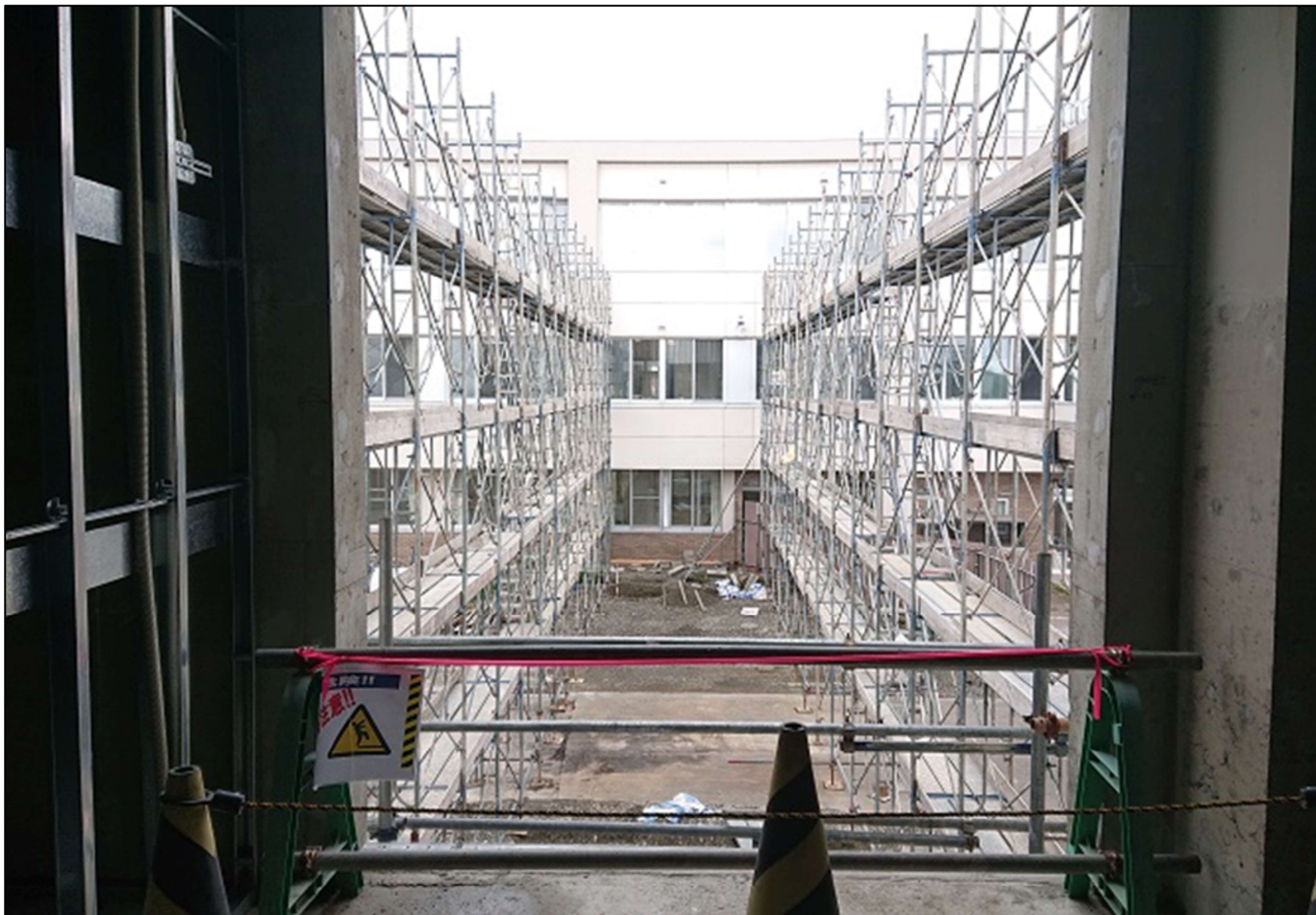
2階より校舎側を望む（将来的に渡り廊下でつながります!!）
