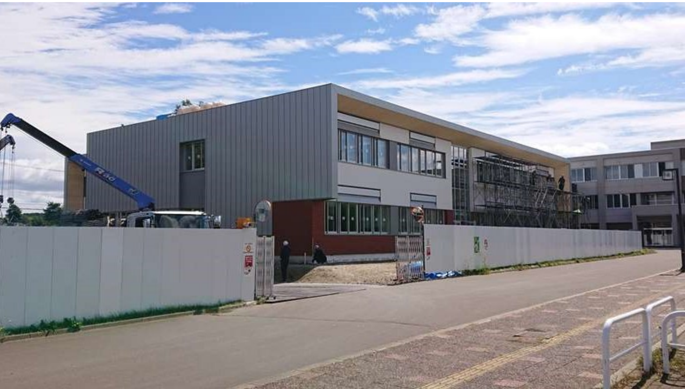
増築校舎棟外観～9月上旬より足場がなくなり外観がはっきり見えるようになりました。
