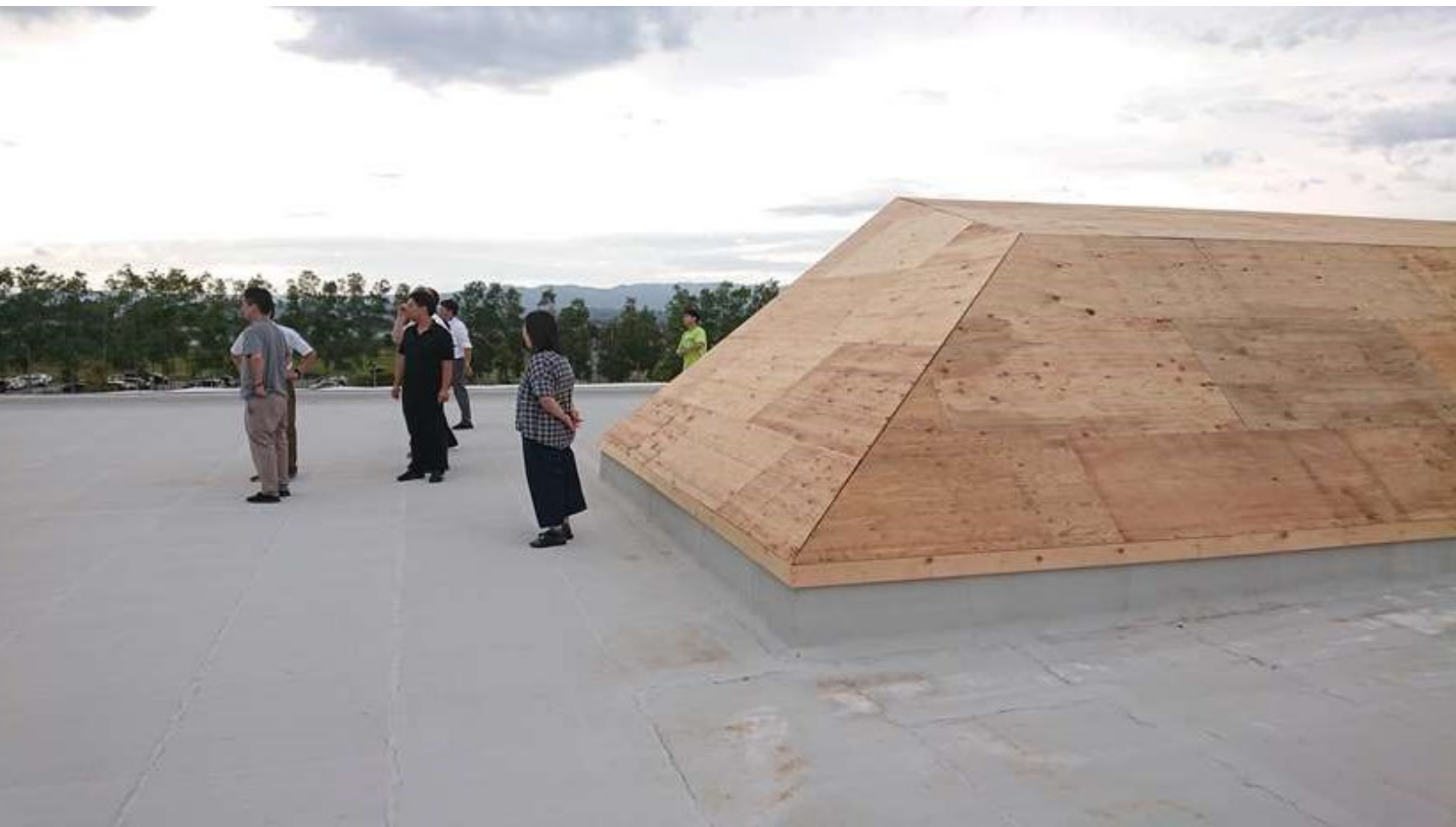
増築校舎棟の屋上（トップライト）
