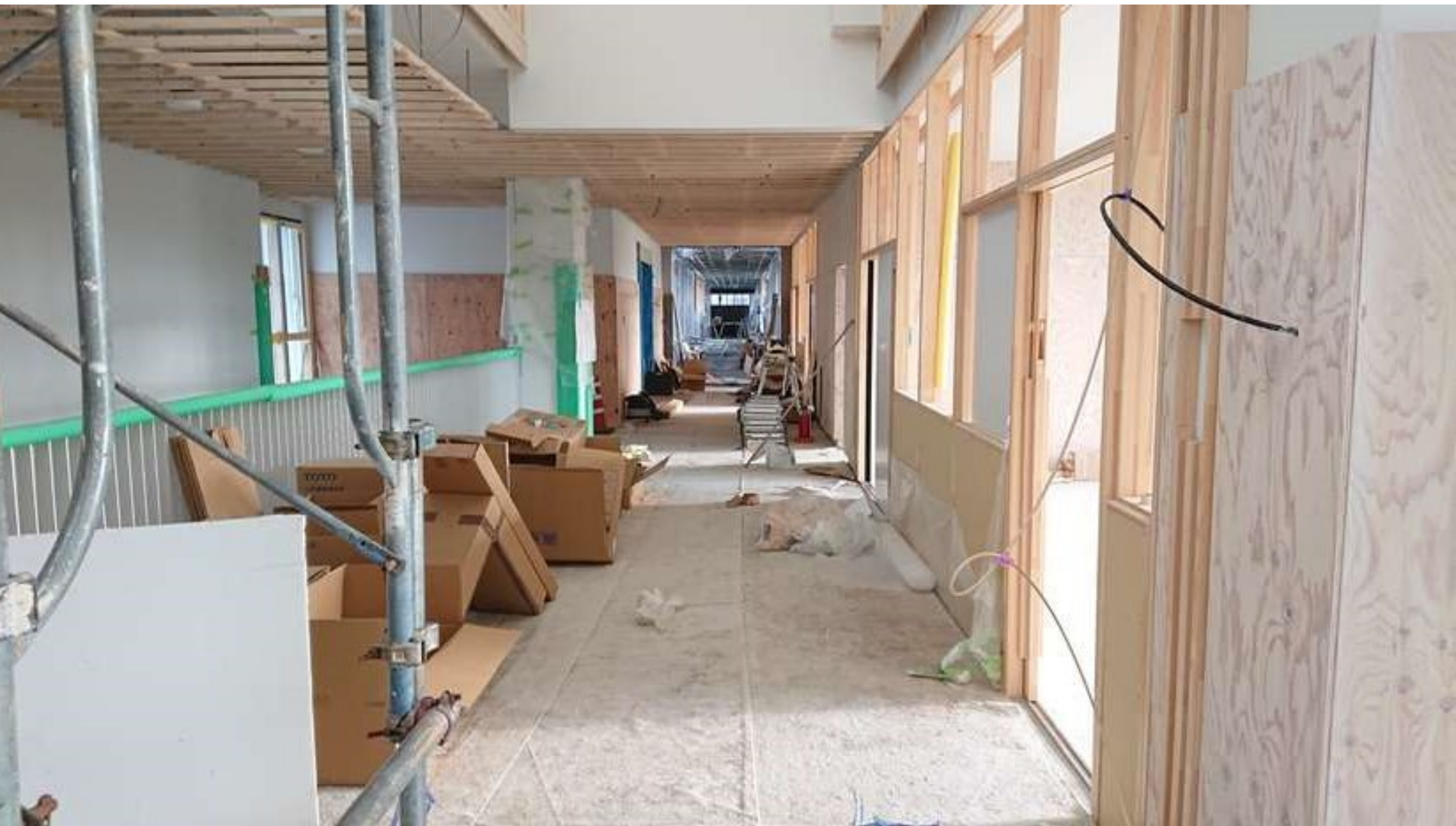
2階廊下その1（増築校舎棟側から現校舎方面を望む）
